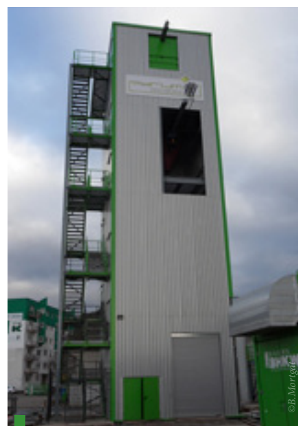
A l'intérieur de cette tour de 25 m, Pyrum Innovations achève la construction de son réacteur de thermolyse
